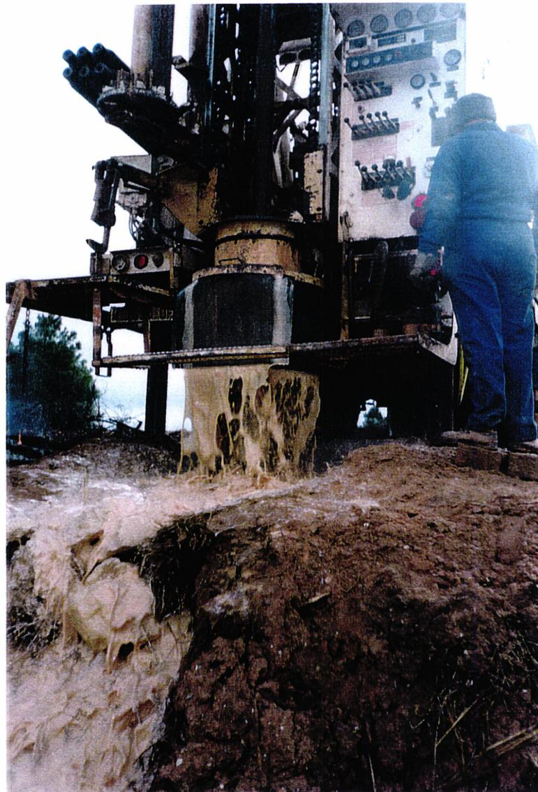
Foto 2. Perforación de Hontecillas II. Detalle. Obsérvese el caudal aproximado, en torno a 3 L/s.
